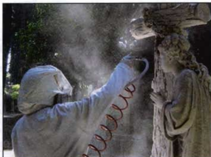
Restauratrice Rita Galluccio durante una fase di intervento per la rimozione di croste nere dal marmo, con pulitura meccanica con microsabbatrice.
